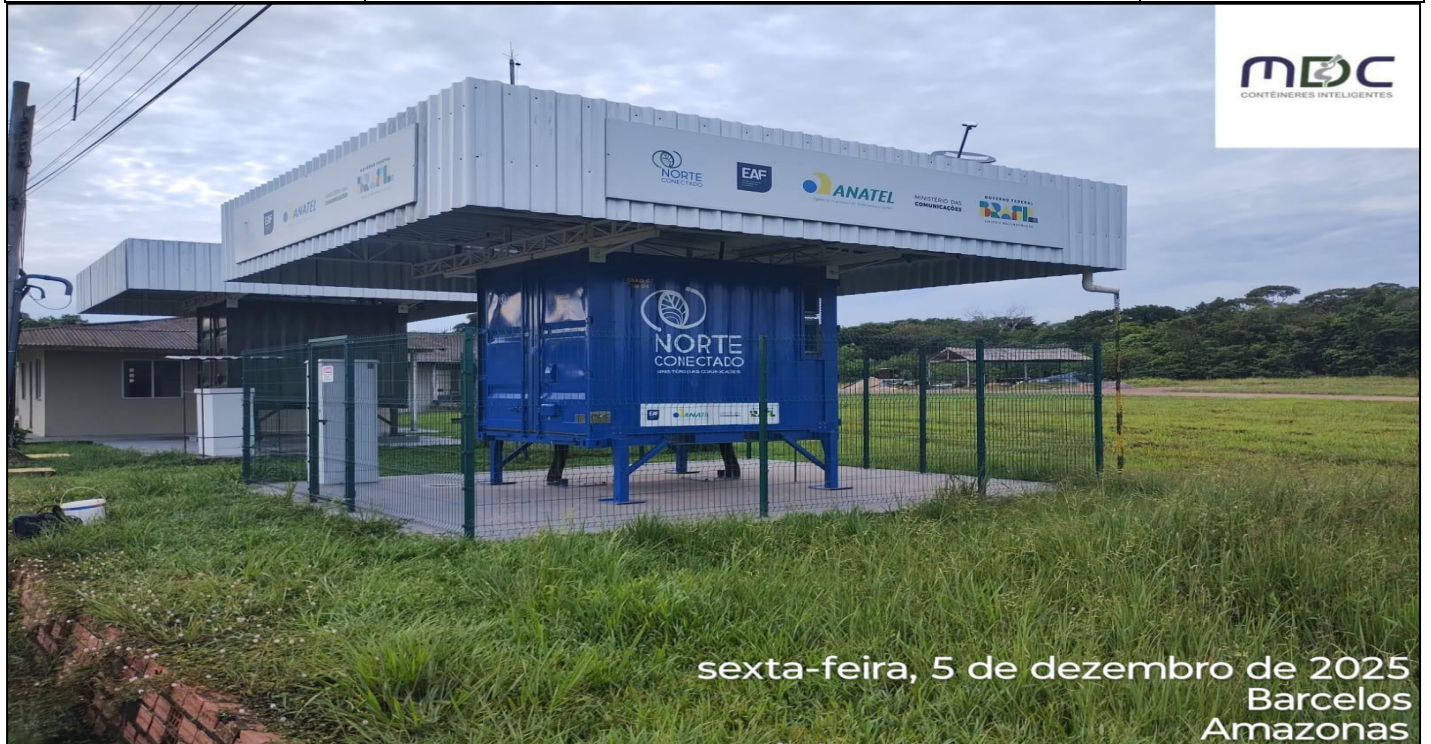
Estrutura geral antes processo de capinagem.
