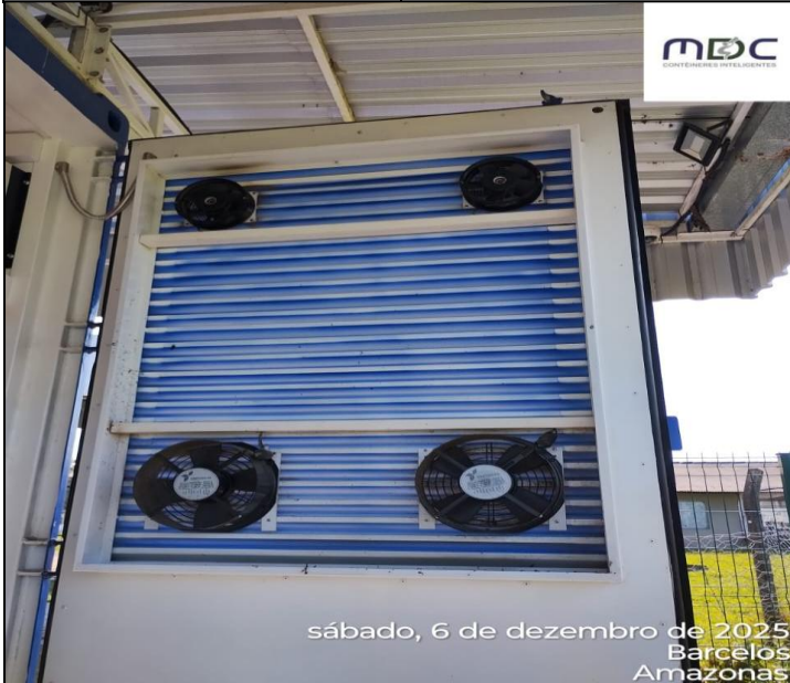
Ventiladores , apresentando condições adequadas de operação.
