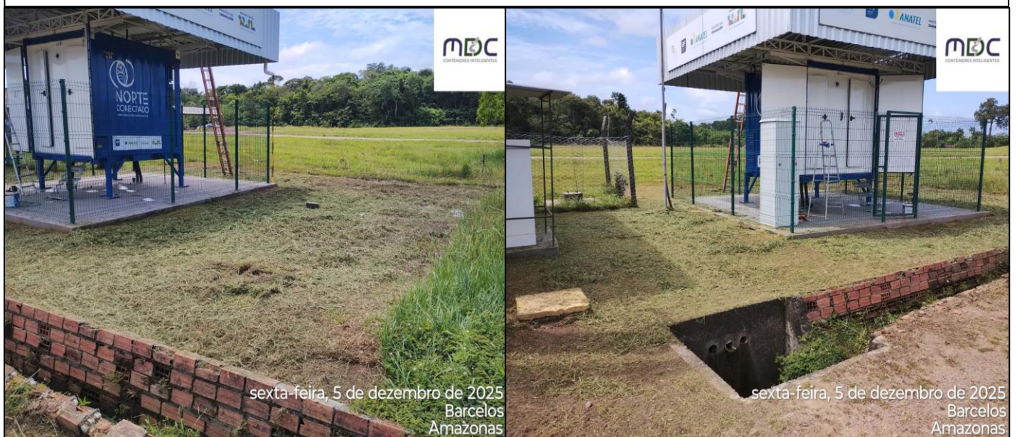
Estrutura geral após processo de capinagem.
